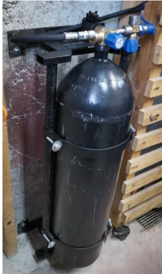
Слика 4.16. Боца за гас монтирана у лабораторији
