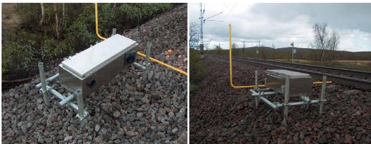
Слика 5.29 Уградња Т/BOGI система на правцу Кируна – Нарвик
