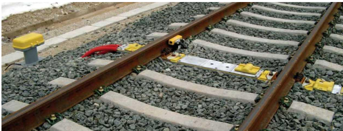
Слика 5.10 Инсталација FÜS II детектора за откривање прегрејаних точкова, лежаја и блокираних кочица
