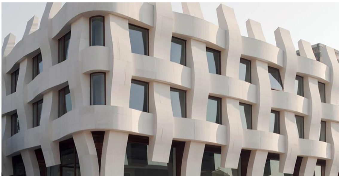
Слика 30. Изглед фасаде са преплитањем елемената на згради „Аргул Вејв“.
