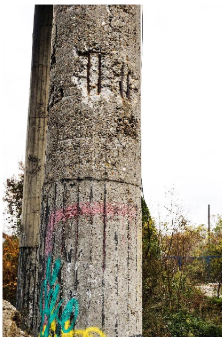
Figure 4.5. Test case: Pančevački bridge column.
