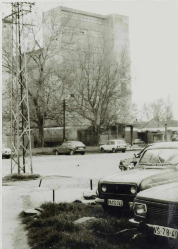
Slika 3. - industrijski miin i pekara u Vrřcu - primer prostorne blizine komplementarnih objekata
