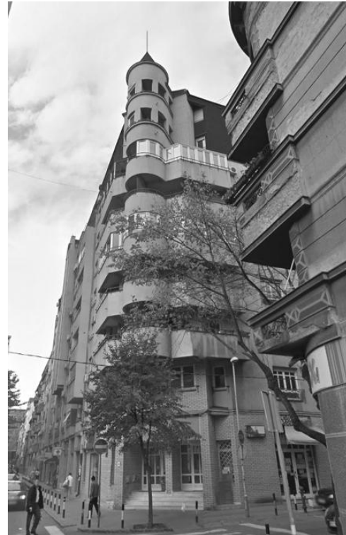
слика 136. Стамбена зграда, 1989, арх. Александар Ђокић, Станоја Главаша 15, Београд ( www.google.rs/maps )
