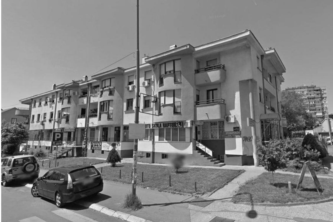
слика 109. Стамбена зграда, после 2000.г., Горњоградска 11, Земун, Београд, ( www.google.rs/maps )
