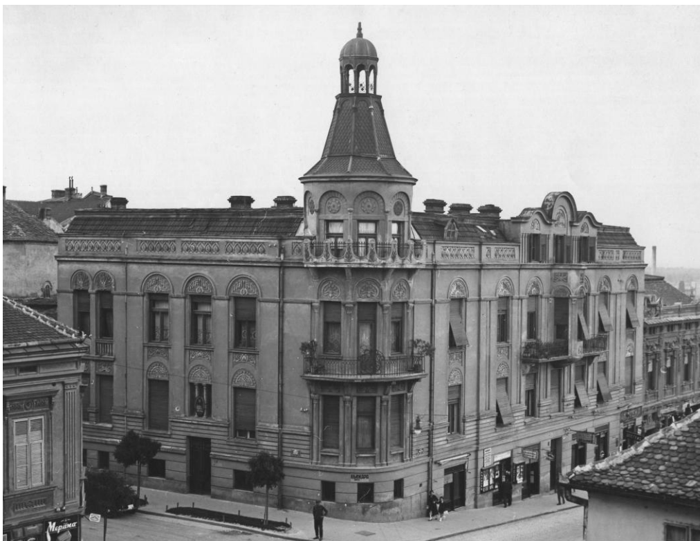
40. Зграда Михајла Бурића, 1910, арх. Јован Ђ. Новаковић, Краља Петра 13, Београд (фонд Б. Несторовића)
