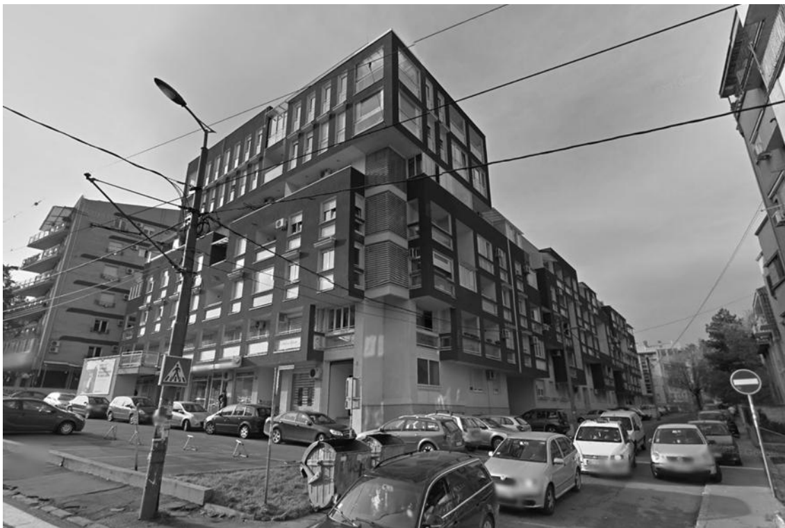
слика 117. Стамбена зграда, 2016, Војводе Стене 74, Београд ( www.google.rs/maps )
