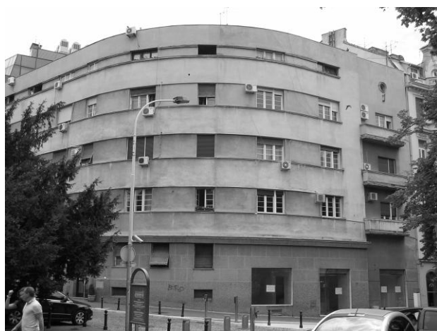
слика 78. Стамбена зграда, 1937, арх. Рађе Михаиловић, Београд (колекција Иван Р. Марковић)
