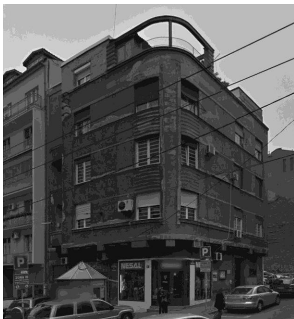
слика 128. Стамбена зграда, 1935, арх. Јан Дубови, Макензијева 21, Београд ( www.google.rs/maps )
