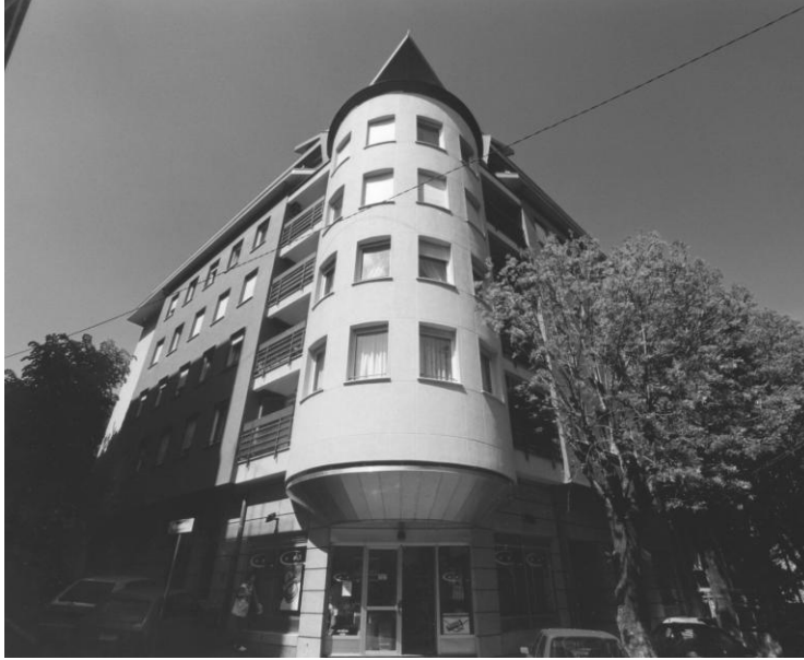
слика 70. Стамбена зграда, 1995, арх. Стеван Мићић, Далматинска 84, Београд (фонд С. Мићић)
