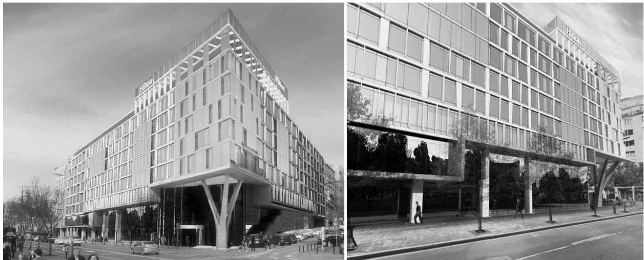
слика 165. Хотел Хилтон, 2018, арх. Игор Марић и арх. Божидар Манић, Краља Милана, Београд ( https://www.creinternational.com/projects/hilton-hotel-belgrade-sr.php )
